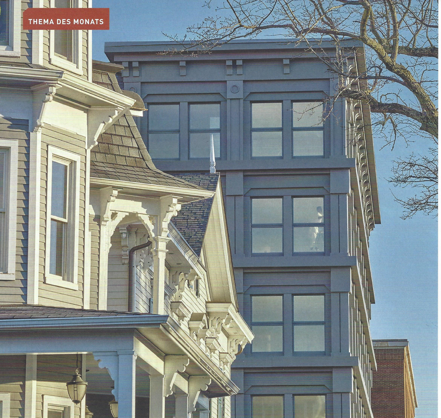
▲ Mit Zinkblech lassen sich die Details der alten Fassaden aus SoHo nachbilden, ohne dabei die Nachteile von Gusseisen in Kauf nehmen zu müssen
