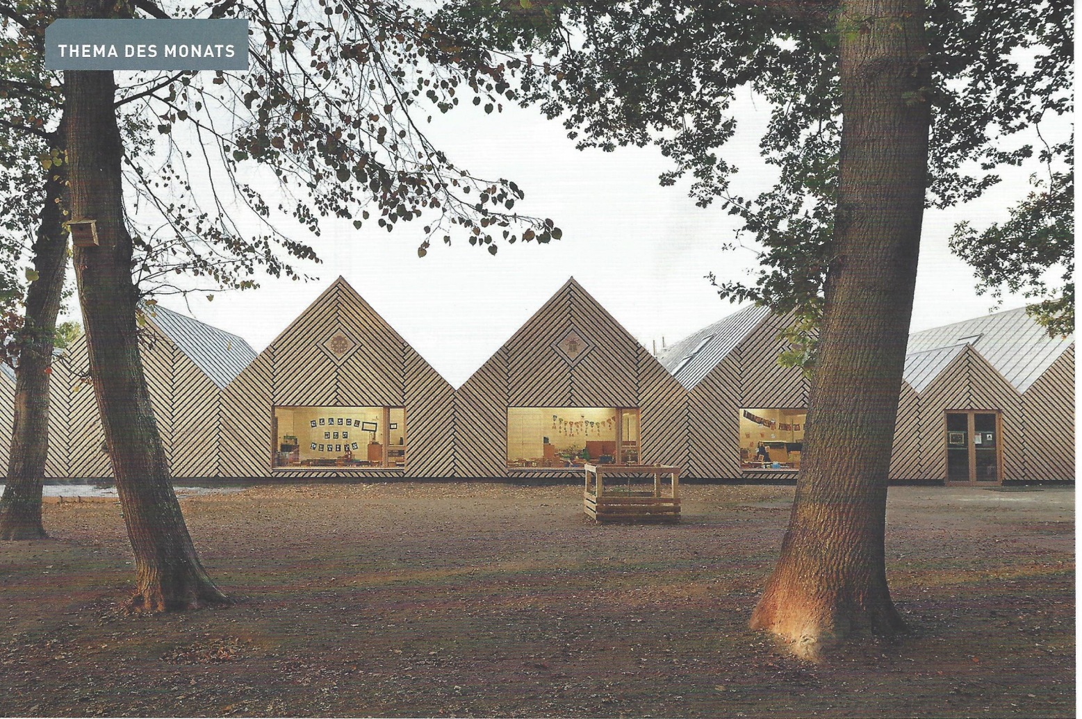
▲ Kleine Häuser mit Holzfassaden und Satteldächern: Die Ausrichtung der hellen Lärchenholzbekleidung folgt dabei stets dem Neigungswinkel der Dächer
