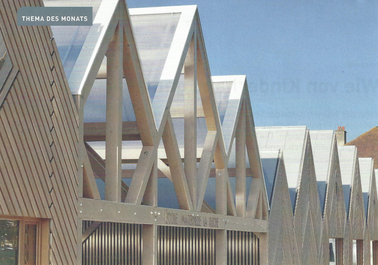
▲ Drei von fünf Dächern mit transparenter Bekleidung aus Polycarbonat: Der große Eingangsbereich bietet den Kindern Schutz bei schlechtem Wetter
